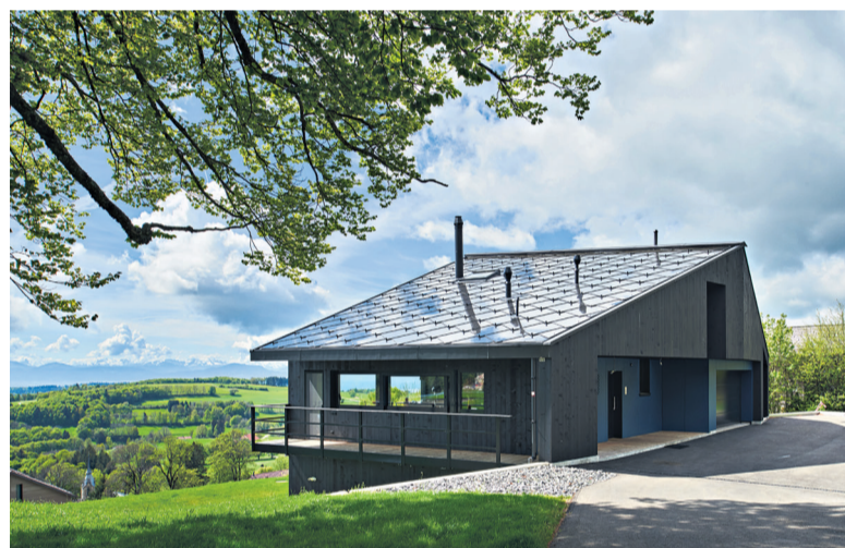
Sur cette maison conçue par le bureau Lutz Architectes, des panneaux solaires d'apparence ardoise s'intègrent harmonieusement dans le paysage du Jura vaudois. (CORINE CUENDERT)
