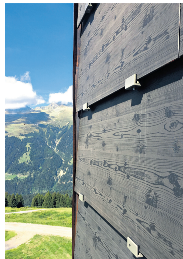
Les panneaux photovoltaïques imitant le bois sur la façade du restaurant Chäserstatt, à Ernen (VS). (ROMAN KELLER/SOLVATEC/AGROLA)
