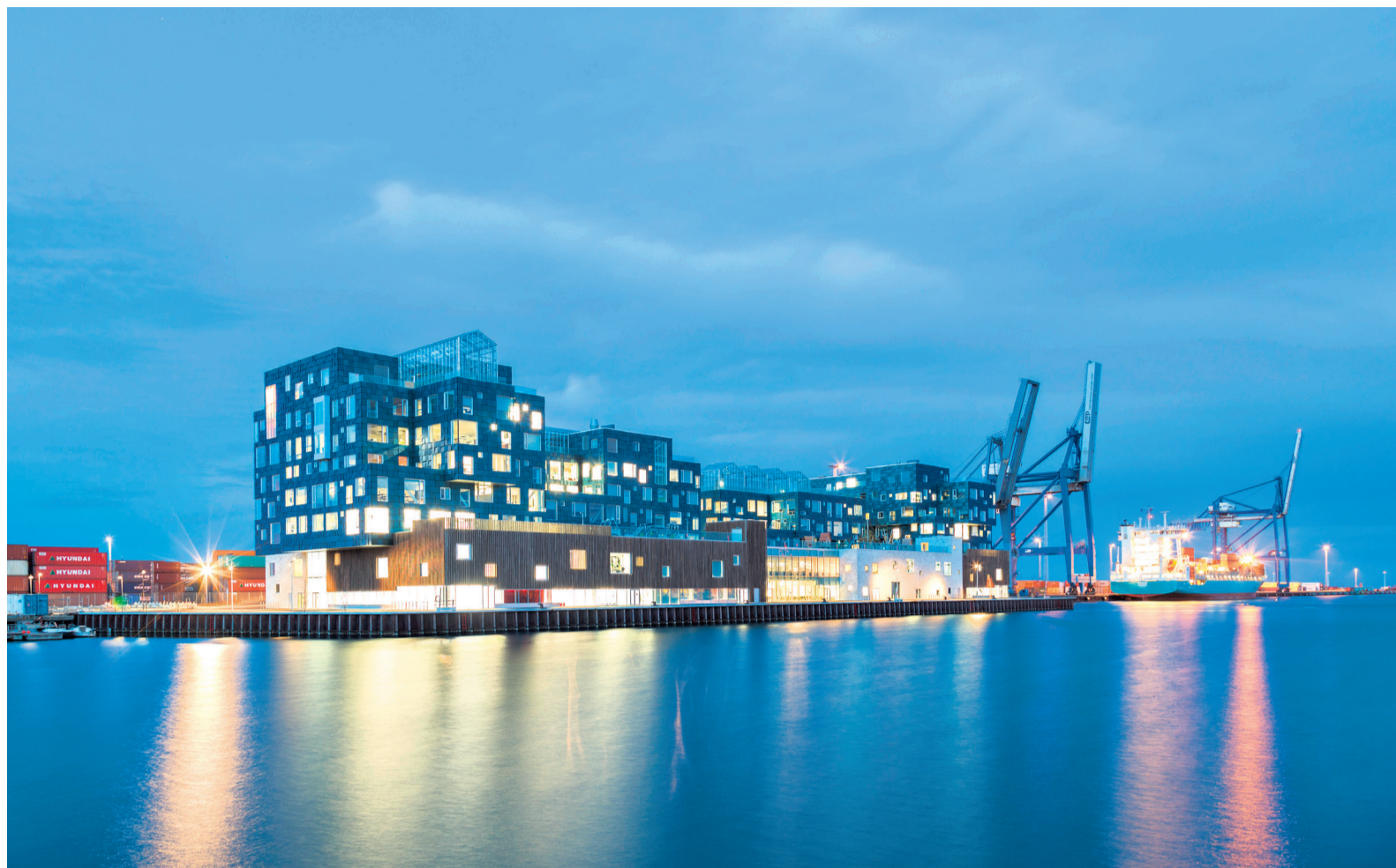
La façade du bâtiment de l'International School de Copenhague est une mosaïque bleu turquoise composée avec le verre solaire Kromatix. (OLIVER FORSTNER/ALAMY STOCK PHOTO)
